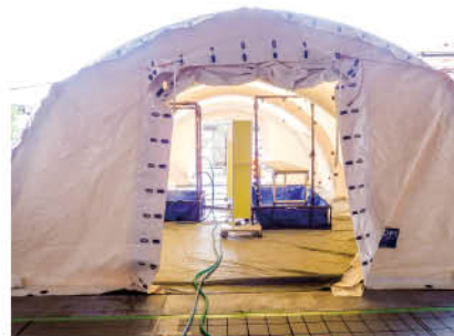
除染のためのテントを救急入口の外に設置
